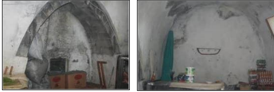
Şekil 4.5. Cimsit Hamamı restorasyon öncesi külhan kısmı (Vakıflar Genel Müdürlüğü, 2020)
