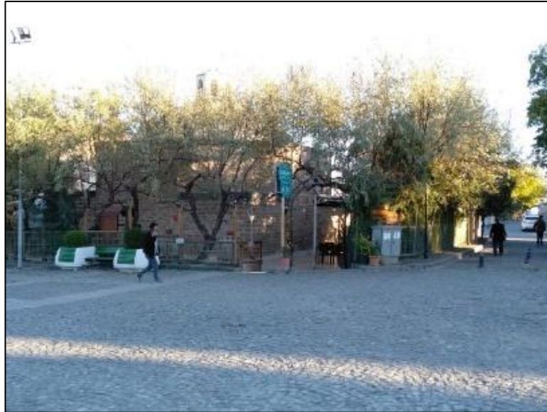
Şekil 2.1.Cimsit Hamamı kuzeyden görünümü(2022)
