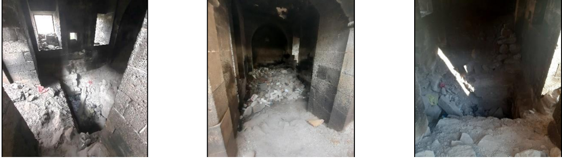
Şekil 2.8. Surp Sargis Kilisesi Vaftiz odasında yapılan kazı ve ateş yakılmasına bağlı bozulmalar
