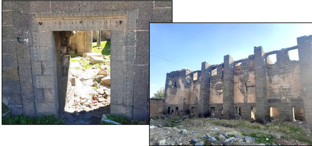
Şekil 2.9. Surp Sargis Kilisesinin güneybatı yönünde bulunan giriş kapısı lentosunun ve cephe duvarlarındaki bozulmalar
