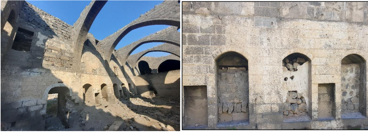
Şekil 2.6 Surp Sargis Kilisesi Naos bölümündeki strüktürel sorunlar
