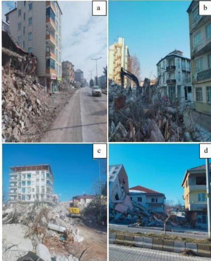
Şekil 1.1. Aynı zemin koşullarında hasar gören ve görmeyen yapılara örnekler. (a: Kahramanmaraş, b: Malatya, c: Gaziantep, d: Adıyaman) (AFAD Kahramanmaraş Depremleri Raporu, 2023)
