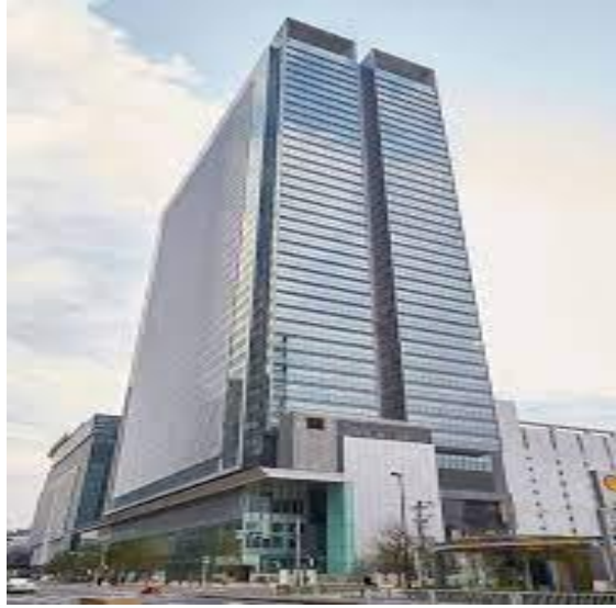
Şekil 2.2. YMÇ'den imal edilmiş sismik damper kullanan Japonya'daki JP Tower Nagoya binası
