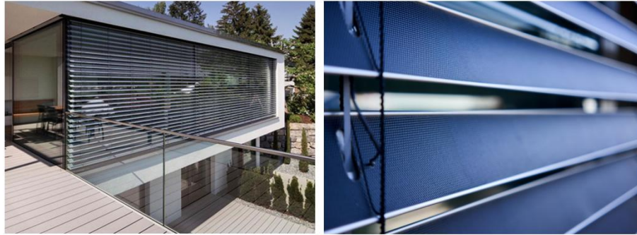
Şekil 1. Yapılarda güneş panelli perde kullanımı
