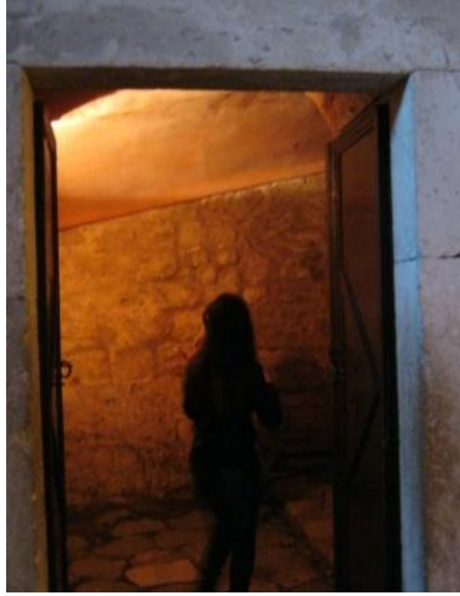
Şekil 3.71. Ayasofya'nın üst katına bağlanan rampaya açılan kapı, (Bilgen, 2011)
