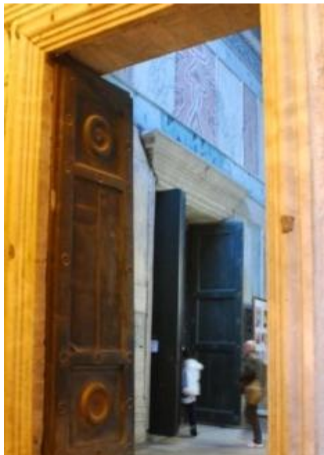
Şekil 3.8. Ayasofya'nın güney dış narteks kapısı (Bilgen, 2011)
