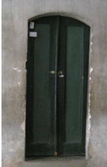
Şekil 3.57. I. Mahmud'un kütüphanesinin kapılarından birinin Ayasofya'nın içinden görünümü, (Bilgen, 2011)
