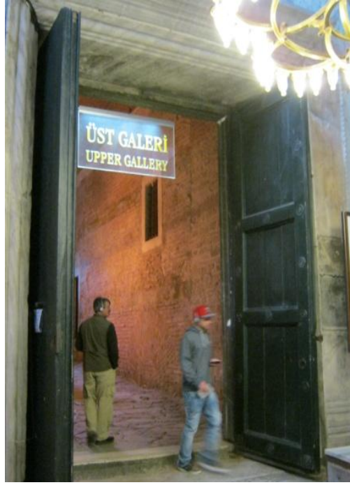
Şekil 3.44. Narteksin güney kapısı (üst kat galerisine çıkan rampaya bağlanır), (Bilgen, 2011)
