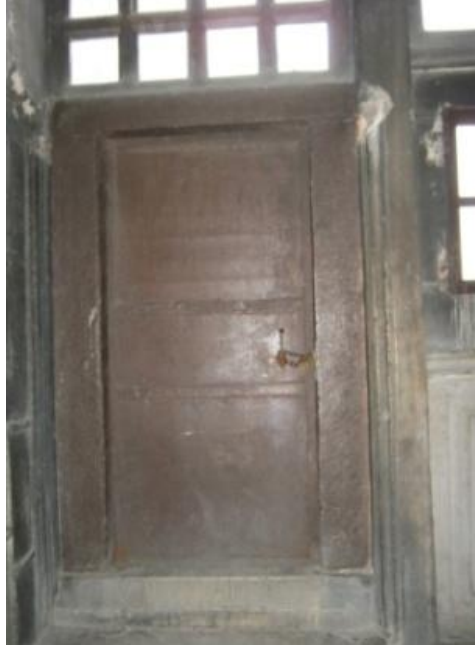
Şekil 3.82. Ayasofya'nın üst katındaki batı galerisinin batı yan duvarındaki kapı, (Bilgen, 2011)
