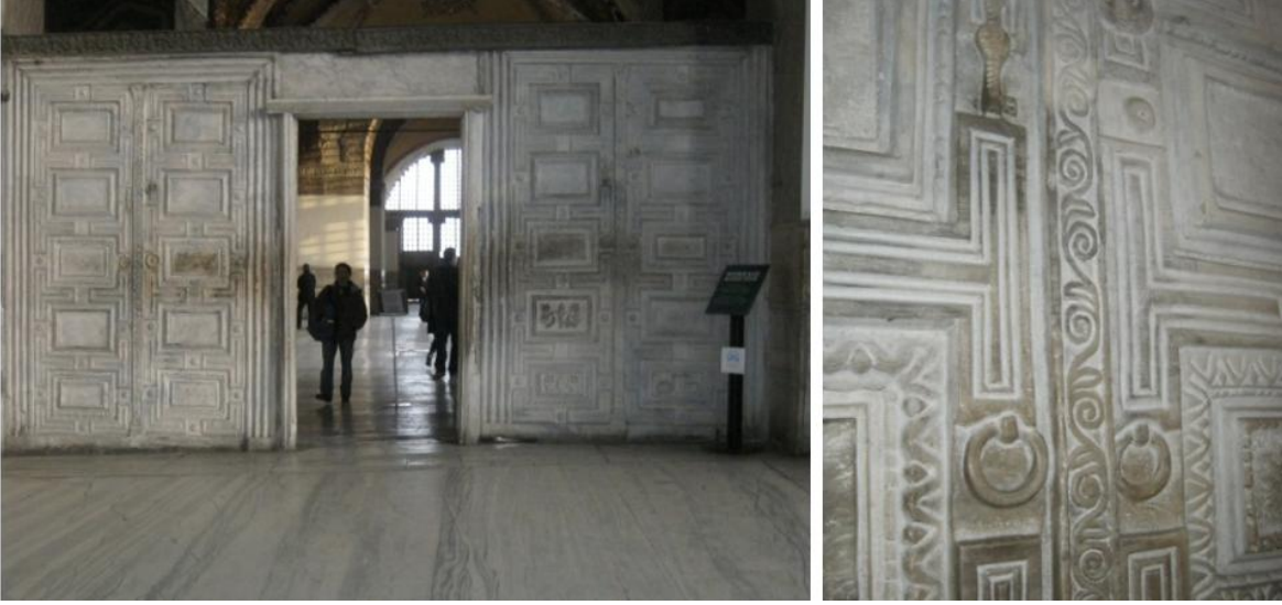
Şekil 3.77. ve Şekil 3.78. Ayasofya'nın Skevophylakion'una (Hazine Binası) bağlanan kapı, (Bilgen, 2011)
