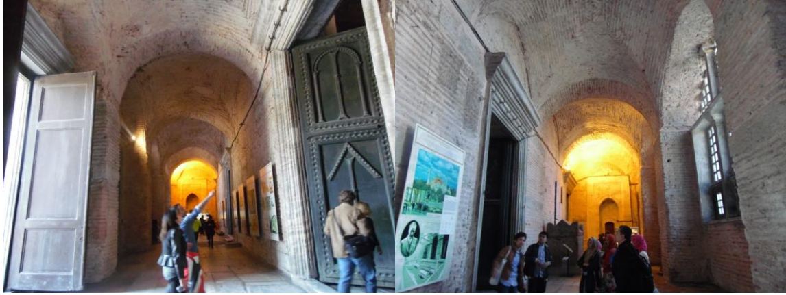
Şekil 3.4. Ayasofya'nın dış narteksi (Akıncı)
