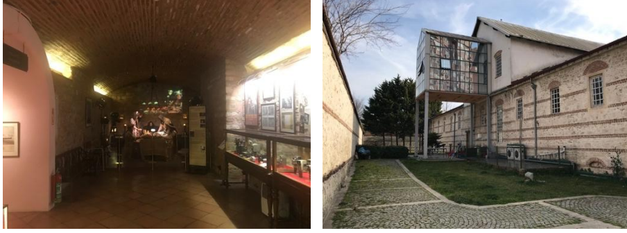
Görsel 11. Lengerhane'nin bodrum katındaki dolgu alanın özgün malzemeyi taklit eden duvar ve kemer dokusu ile eklenen mekanı (solda) ile İspirtohane'nin doğu cephesinde günümüze ulaşmadığı için çağdaş malzemelerle eklenen çıkması (sağda)
