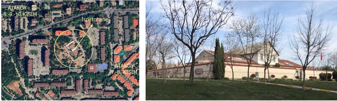
Görsel 3. İspirtohane'nin konumu ve girişinin bulunduğu güney-batı cephesinden görünümü
