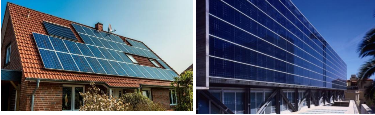
Şekil 2. Binanın çatısına sonradan tespit edilen ve bir binanın cephesinde kullanılan FV Paneller
