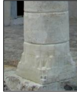
Batı Cephesi Sütun Alt İşlemeleri
