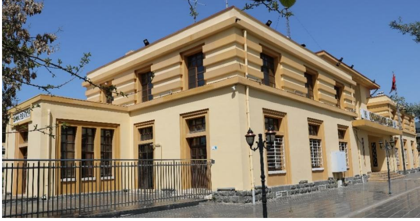
Foto. 19: Yapının güney kanadı
