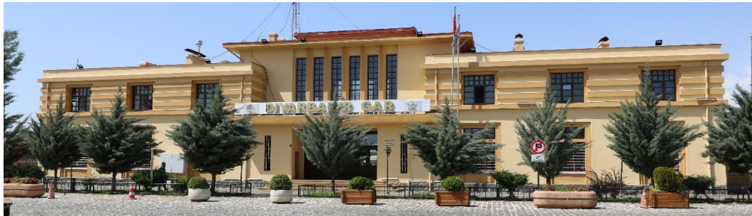
Foto. 5: Garın batı cephesi
