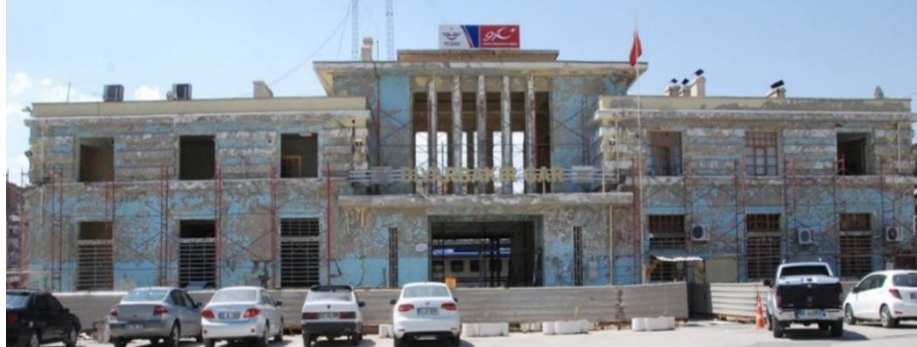
Foto. 4: Diyarbakır Tren Garı restorasyonu- 2015
