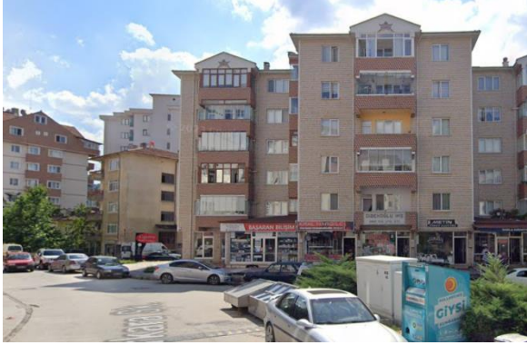
Balkonların Cephe Bütünlüğüne Aykırı Olarak Farklı Malzemeler ile Kapatılması (Kaynak: Google Maps, 2023).
