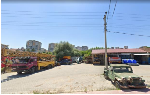
Elektrik Direkleri, Kabloları, Telleri (Kaynak: Google Maps, 2023).
