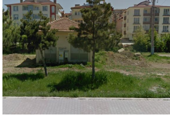
Trafo Binaları (Kaynak: Google Maps, 2023).
