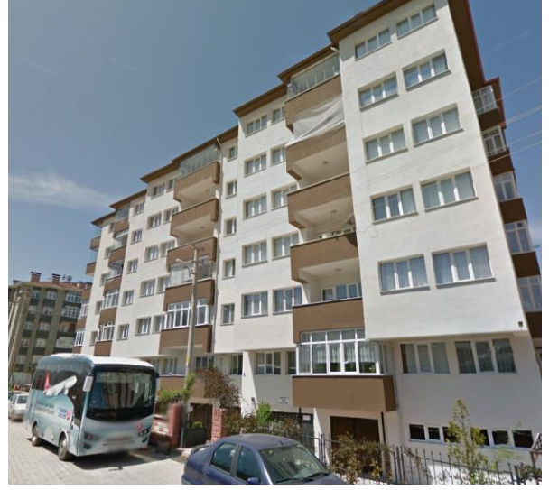
Balkonların Cephe Bütünlüğüne Aykırı Olarak Farklı Malzemeler ile Kapatılması (Kaynak: Google Maps, 2023).
