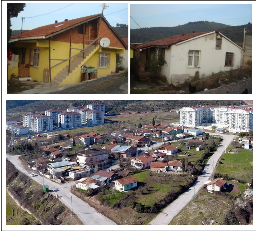
Şekil 4. 8. Araptepe Kentsel Dönüşüm Proje Alanı Eski Hali
