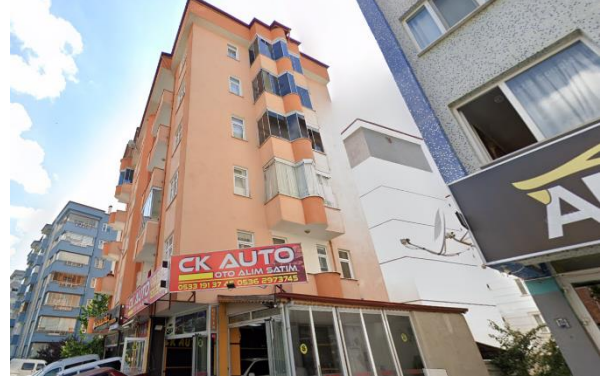
Balkonların Cephe Bütünlüğüne Aykırı Olarak Farklı Malzemeler ile Kapatılması (Kaynak: Google Maps, 2023).
