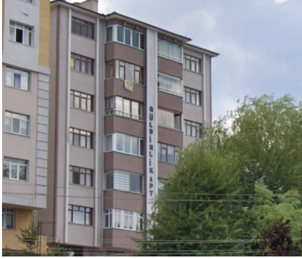
Görsel 9: Yarı Açık Olan Alanların ya da Balkonların Cephenin Bütünlüğüne Aykırı Olan Farklı Malzemelerle Kapatılması Örnekleri.
