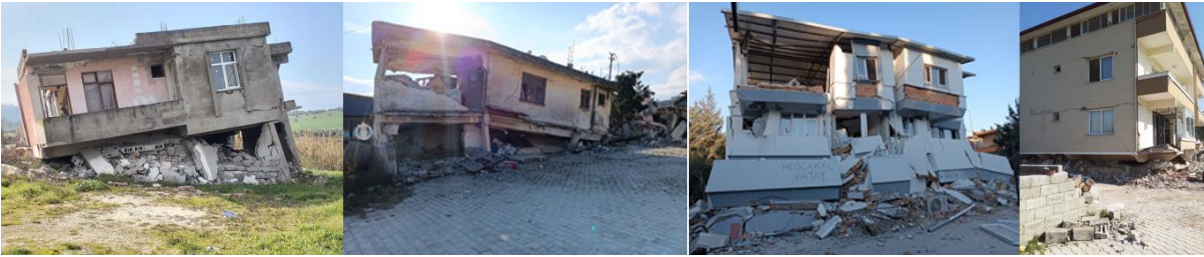
Şekil 3.1. Zemin katları kısmen ve tamamen göçmüş betonarme yapı örnekleri
